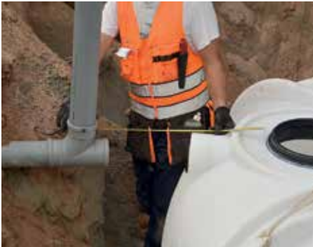
Tee liitokset huolellisesti.
