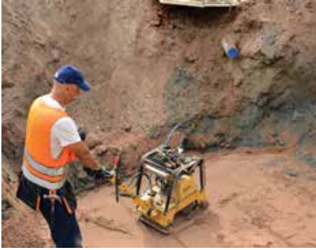
Tasoita ja tiivistä säiliön pohja huolellisesti.
