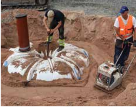
Tiivistä kaivanto 20cm kerroksissa väillä tiivistäen.
