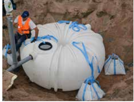
Ankkuroi umpisäiliö vähintään neljästä eri kohdasta.
