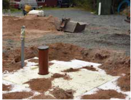
Eristä kaivanto ja viemäriputki routaeristelevyillä.
