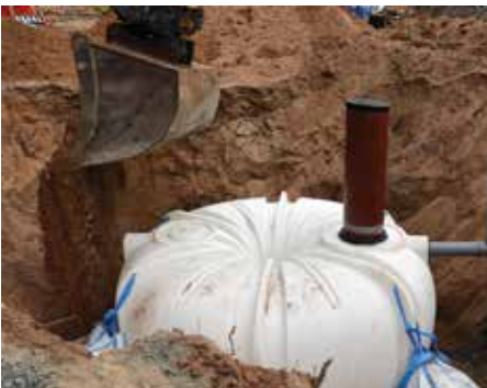
Täytä kaivanto varoen asennushiekalla.
