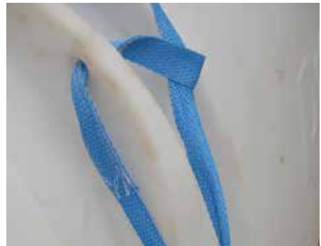
Pujoita liina umpisäiliön ankkurointikorvan läpi.
