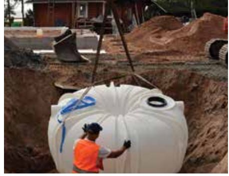
Säiliö nostetaan ankkurointikorvista liinoilla.
