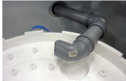
Kuva 6. Vesilukko voidaan ottaa pois käytöstä poistamalla putken kulma tai kääntämällä se kuvan tavalla sivulle.
